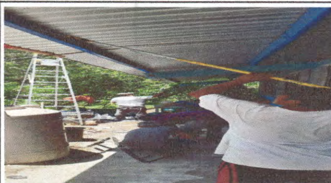
Foto 8: Mantenimiento a soporte de estructura de metal.
