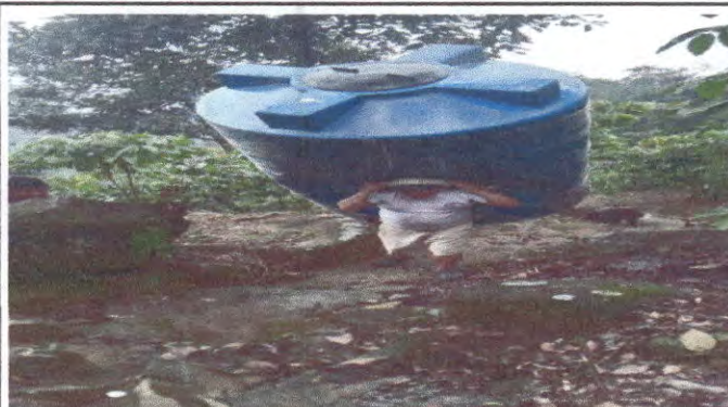
Foto 4: Sustitución de deposito de agua 1100 lt
