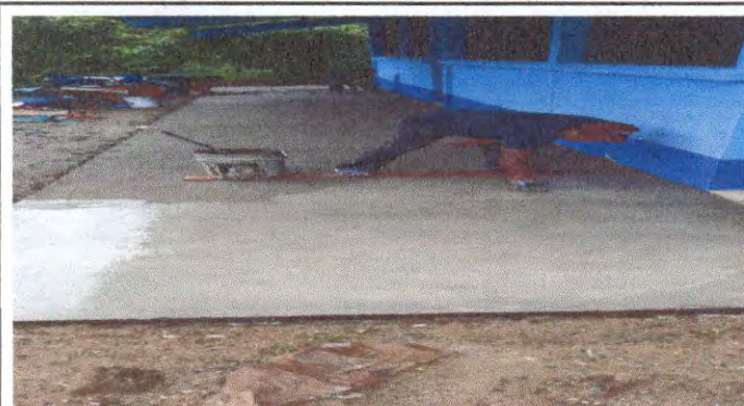
Foto 9: Reparación de piso de torta de concreto
