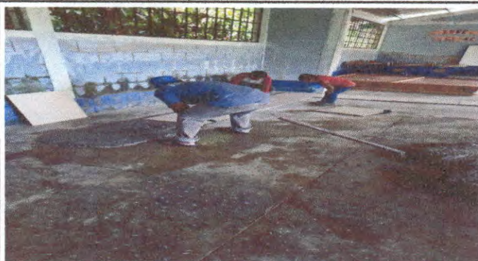
Foto7: Sustitución de piso torta por ceramico.
